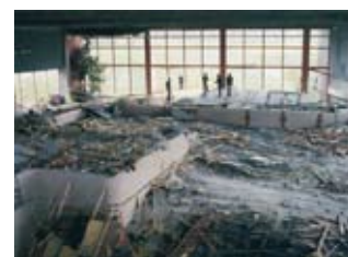
V roce 1985 povolil zavěšený betonový strop krytý plovárnou v Ústeru, ve Švýcarsku. Stropní spojovací prvky z nerezavějící oceli nevykazovaly žádné vnější známky poškození, ale uvnitř byly v některých případech zcela zničené v důsledku popraskání způsobeného korozi napětím
