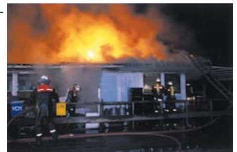
Obr. 1: Požár restaurace Aussenalster v Hamburku Budova: Převážně dřevěná, jednopatrová, Postavená na dřevěných pilotech Příčina požáru: Technická závada elektroinstalace, pravděpodobně následkem únavy materiálu Škody na budově: Zničení až na piloty a trémový rošt Výše škody: cca. 0,5 mil. EUR
